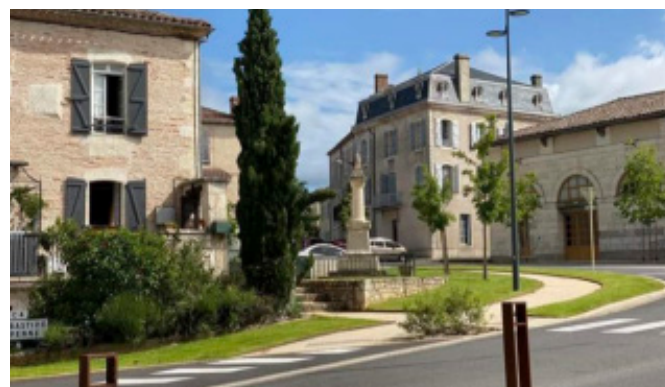
Aménagement de la RD 17 en travers du village de Puylaroque
