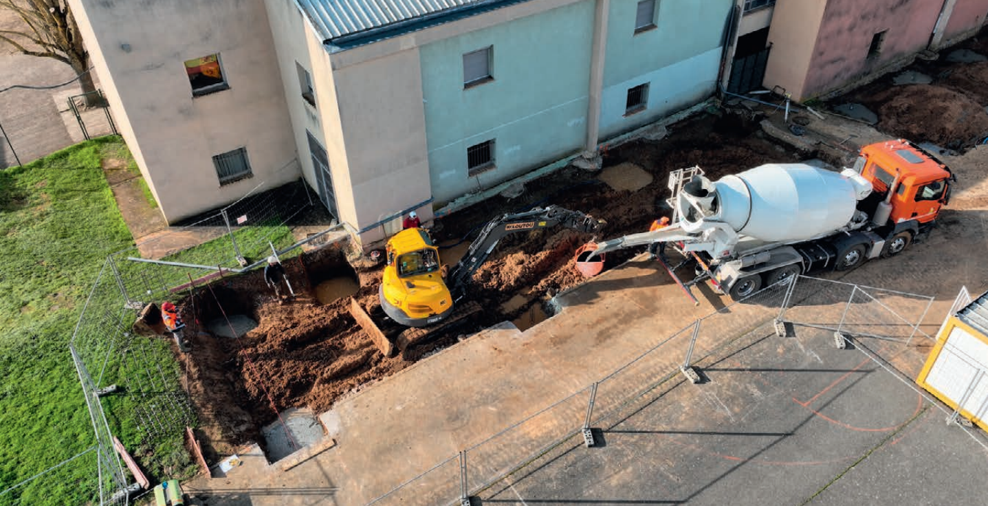
Travaux d'extension du collège Jean-Jacques Rousseau de Labastide-Saint-Pierre.
