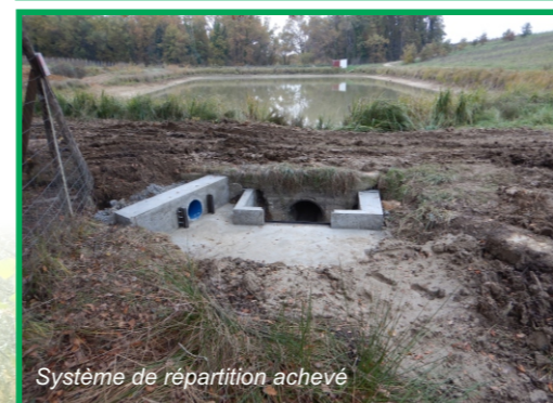
Réalisation du déversoir
