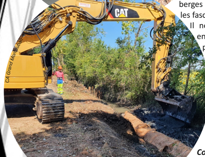
Remplissage des banquettes
