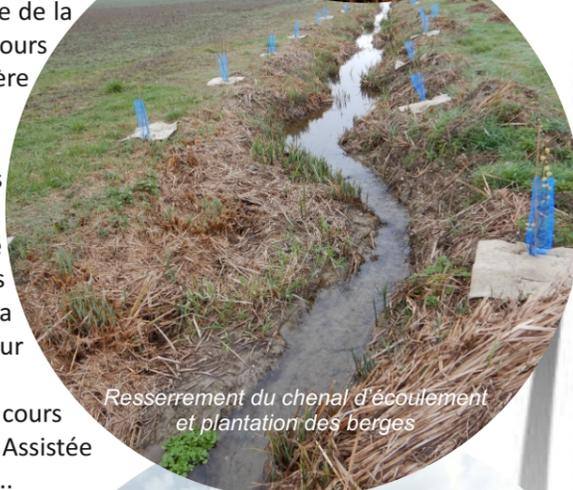
Resserrement du chenal d'écoulement et plantation des berges
