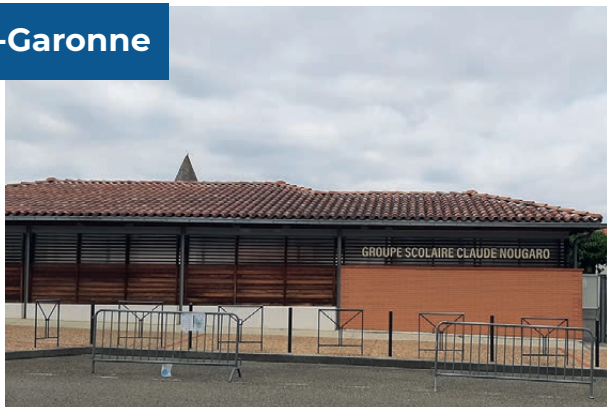
Travaux de réhabilitation énergétique, école de Saint-Sardos.
