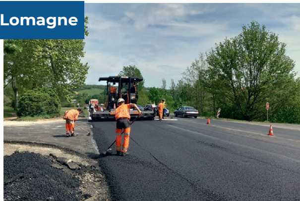
Chaussée de la RD 928, Larrazet.
