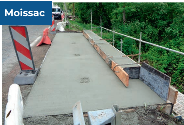
Pont de Nauze, RD 813, Moissac.
